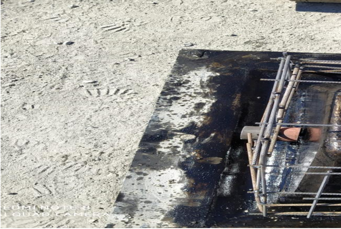
*Beton sıvatlarda kullanılacak Manşon detayı
