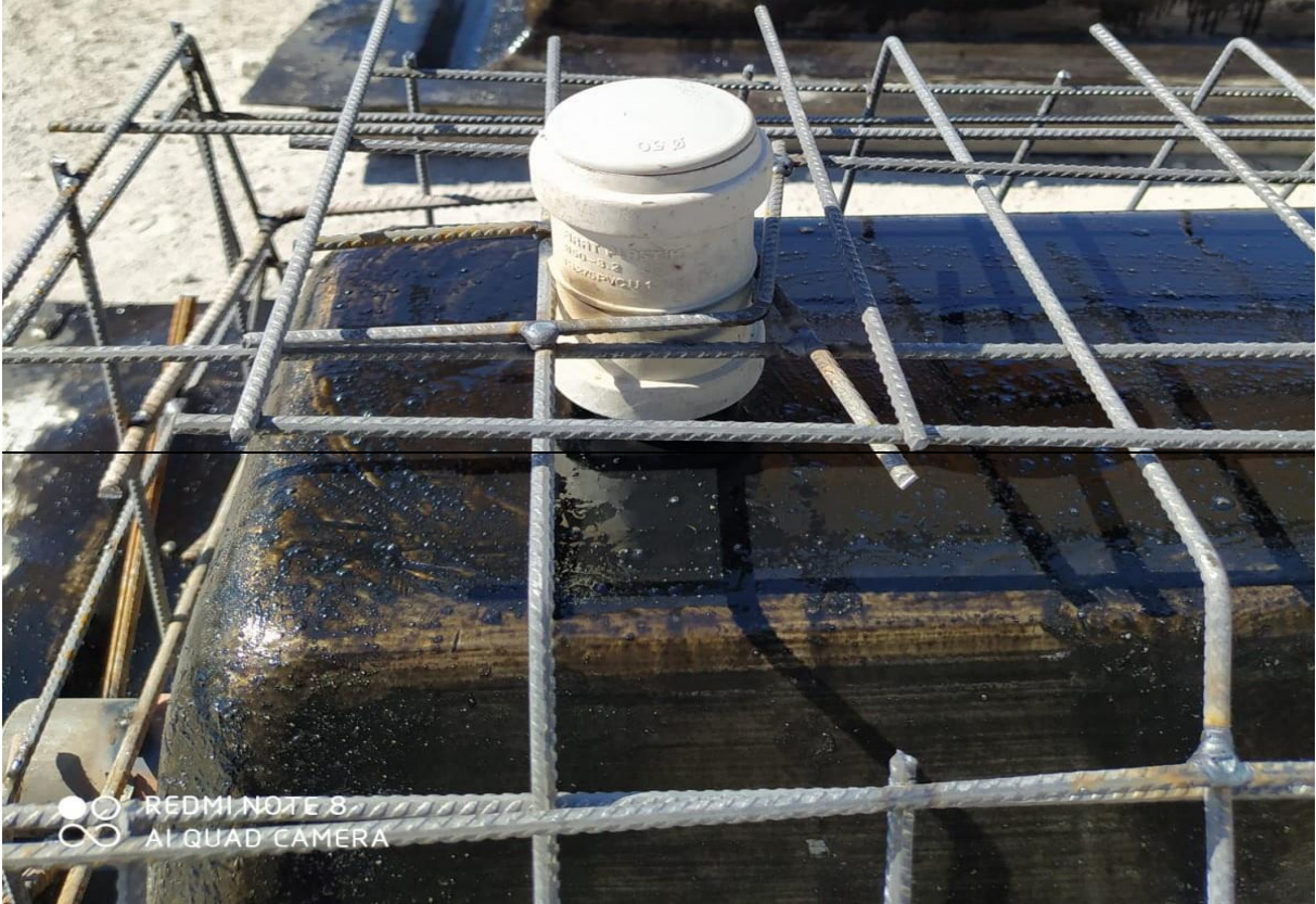
*Beton sıvatlarda kullanılacak Kör Tapa detayı
